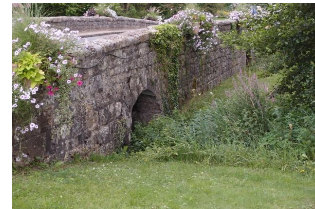
Vieux pont en pierres occupé occasionnellement par les chiroptères
